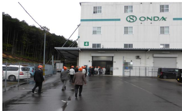
地中熱利用空調設備の見学
