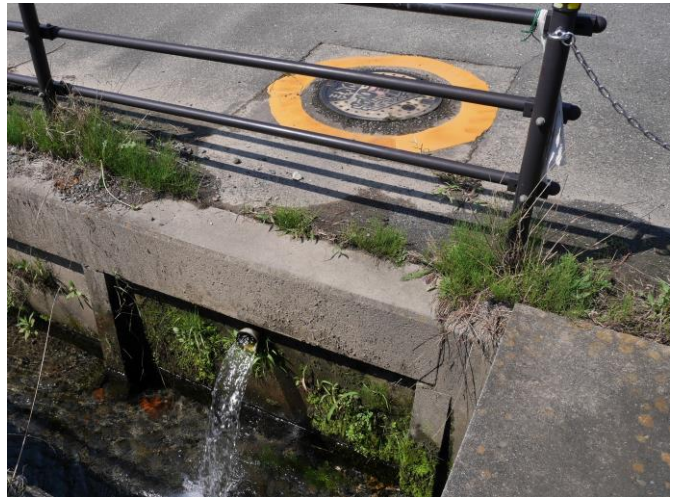
消防用水にも湧水が使われています。 普段は用水路に「垂れ流し」(大垣市)
